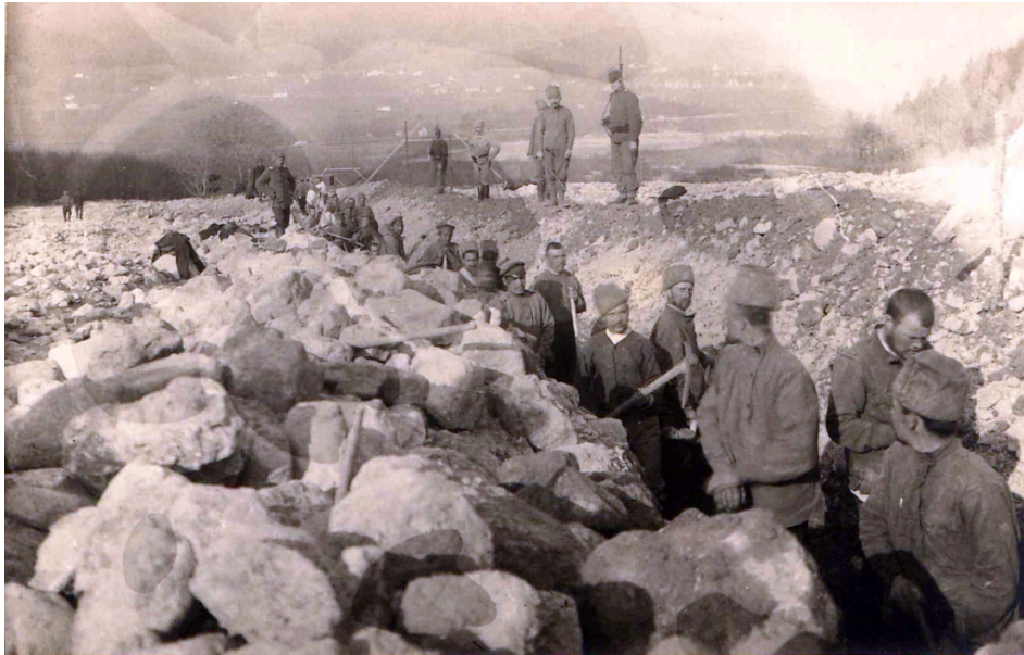
Abbildung 10: Russische Kriegsgefangene wurden als Arbeitskräfte zur Errichtung des sogenannten Russendamms an der Schesa eingesetzt und waren im Gemeindeschuppen von Bürs notdürftig untergebracht. (Foto: Sammlung Josef Concini)
